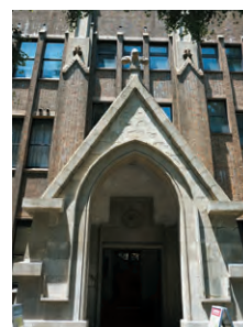
現在の法学部1号館
